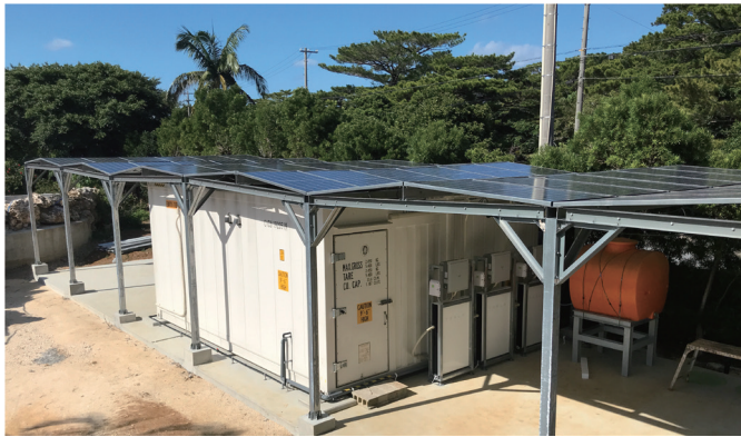
写真 1. 植物工場実験施設（外観）
